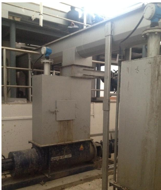
图 2.4-6 脱水沼泥的密闭输送与提升
