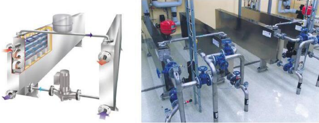
图 2.4-5 泥水换热器原理示意图及实景图
